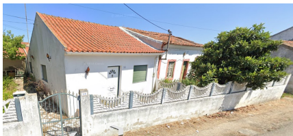
Fig. 2 – Fachadas do existente, antes das obras
