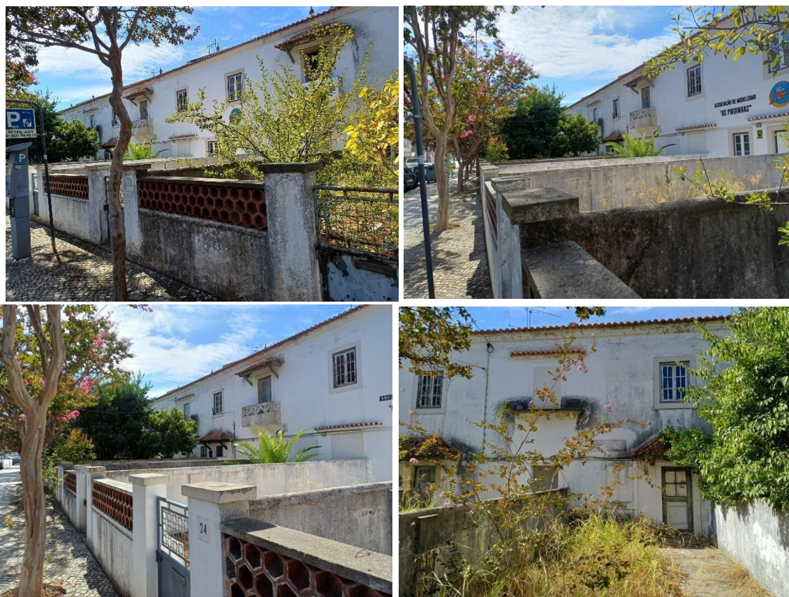
Fotos 14 a 17 – Bairro da Estação
