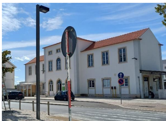
Fotografia 17 – Edifício da CP na Rua Latino Coelho
