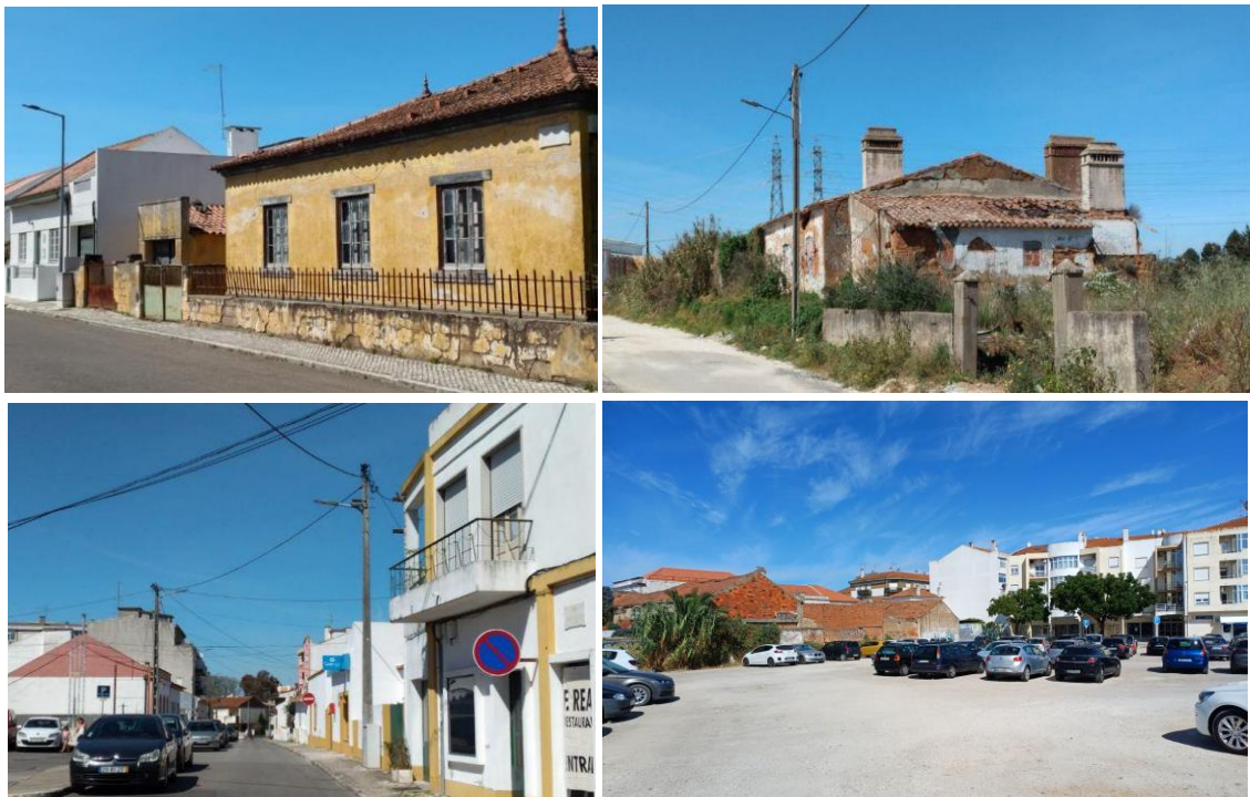
Fotos 09 a 12 – Exemplo de edifícios em mau ou razoável estado de conservação
