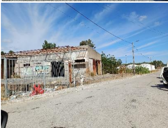
Fotos 10 a 12 – Edificado do Bairro Social Frederico Ulrich e zona industrial desativada
