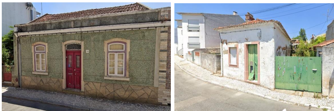
Fotografia 05 – Edifícios em mau estado de conservação na Rua 1 o Dezembro e na Rua Elias Garcia
